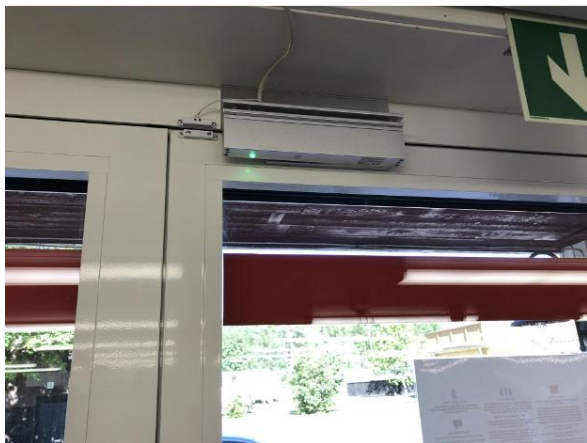
Monteringseksempel inngangsdør som går utover
