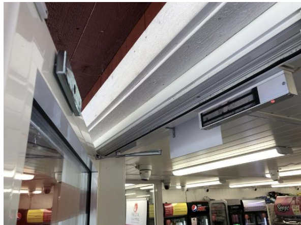
Monteringseksempel inngangsdør som går utover
