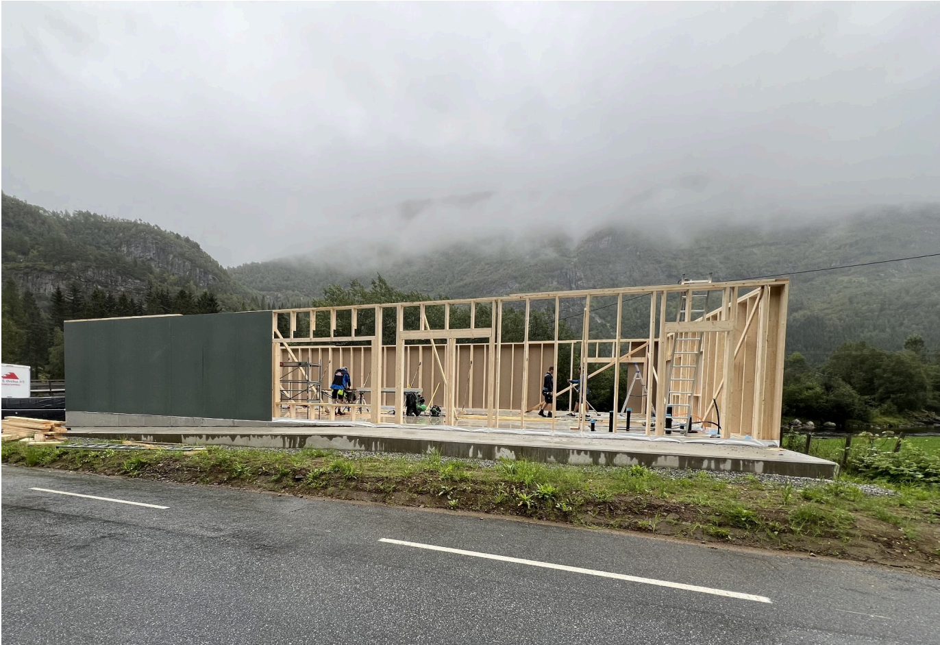
I ARBEID: Tre tilsette frå firmaet Johs. E. Øvsthus AS byggjer butikken. Foto: Privat
