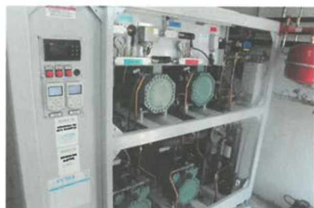
CO 2 : Lars Bråten har bygd et nytt maskinrom bak butikken som huser CO 2 -anlegget.
