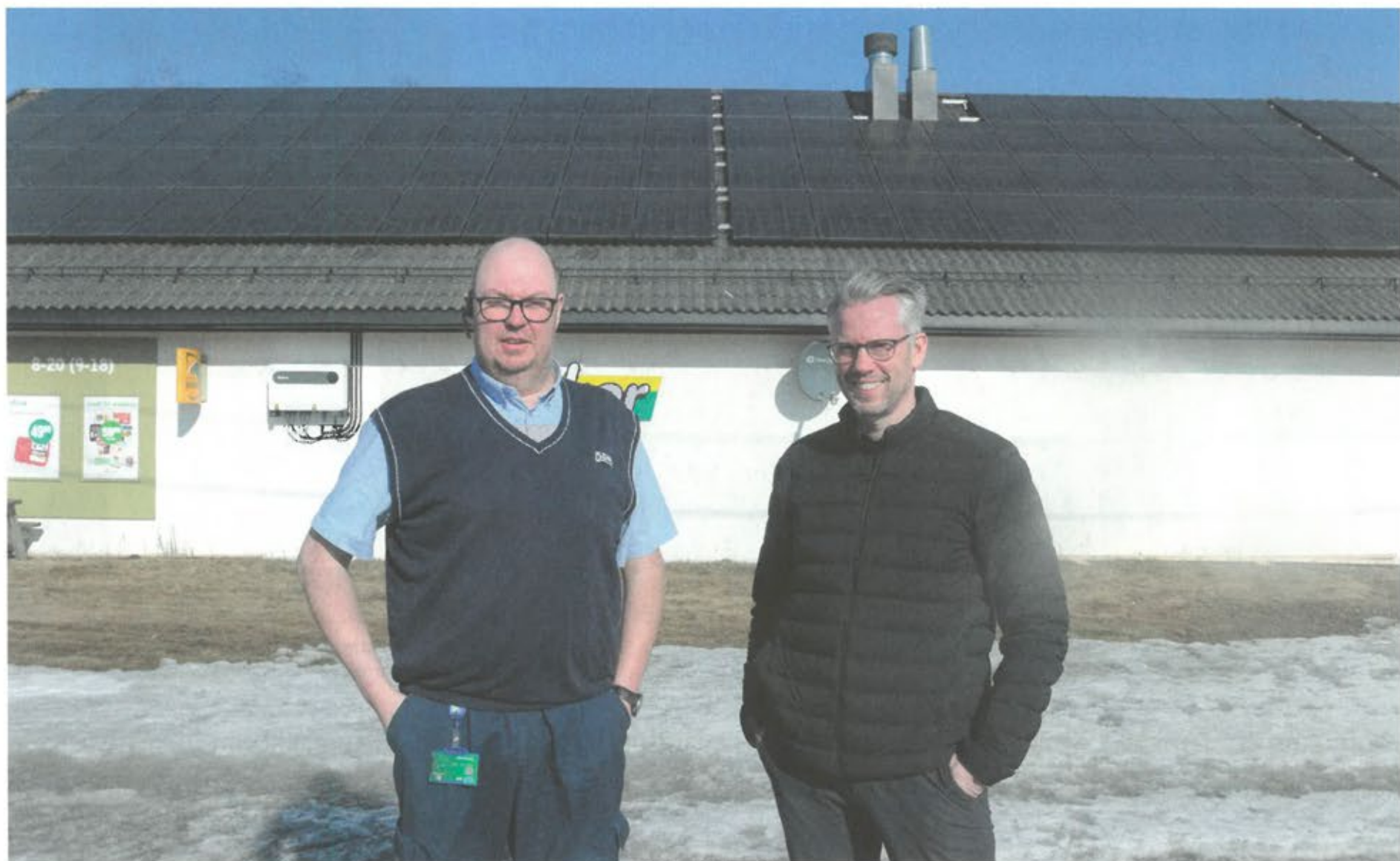
GEDIGENT PANEL: Kjøpmann Lars Bråten og bærekraftsansvarlig i Kjøpmannshuset, Frank Ellingjord-Dale, foran Joker Brandval. Legg merke til solcelleanlegget på taket.
