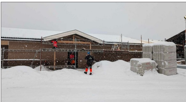
På byggeplassen er det aktivitet både ute og inne i snøværet.
