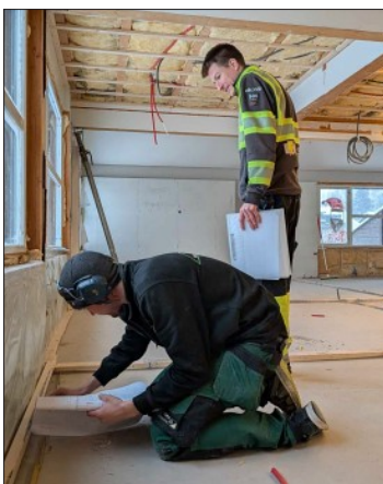
Elektriker Robin Lunde (t.h.) i Lesja Dovre Elektro, og Aslak Brækken i Jora Bygg og Laft samarbeider på prosjektet.
