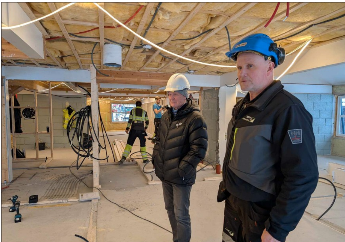
Prosjektleder Arild Killi (t.v.) og formann Geir Groven i Jora Bygg og Laft følger byggearbeidet i den «nye» barnehagen på Dovre. ALLE FOTO: SIMEN RUDILØKKEN
